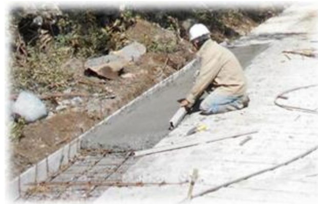
Imagen 23. Fundición de cunetas.
