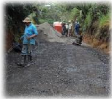
Imagen 9. Regado y compactación de material.
