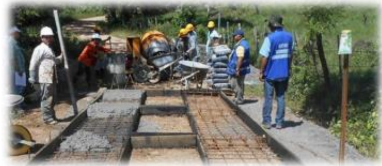
Imagen 15. Preparación de Concreto Hidráulico clase D (3000 Psi).
