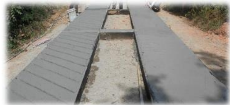
Imagen 18. Rayado en forma de esqueleto de pescado.
