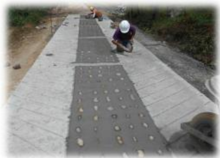
Imagen 19. Fundida de la placa central.
