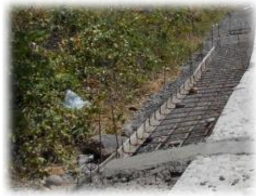
Imagen 22. Acero de refuerzo para cunetas.
