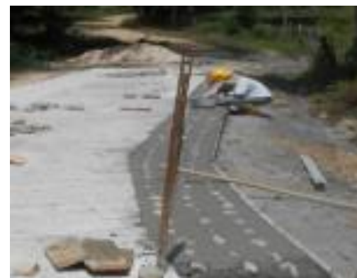
Imagen 20. Fundida de sobre anchos.
