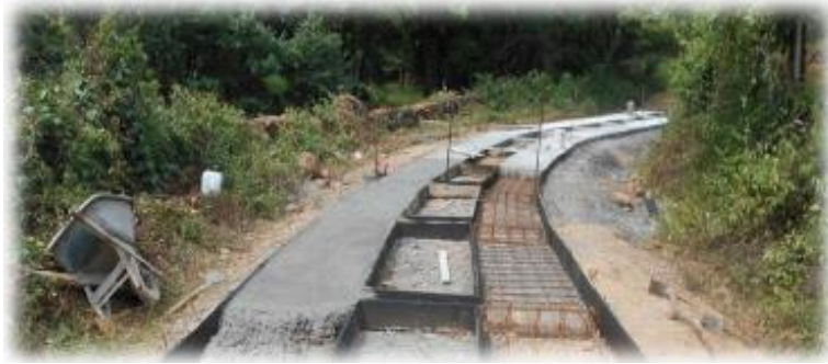
Imagen 16. Fundición de placa huella Municipio de Oiba.
