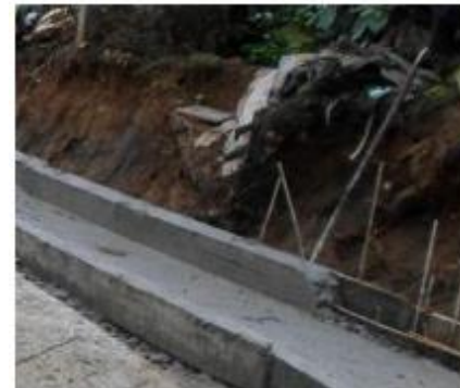
Imagen 24. Construcción de bordillo lateral
