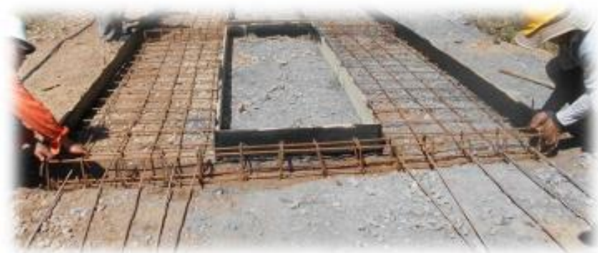
Imagen 13. Ubicación de Vigas de refuerzo.
